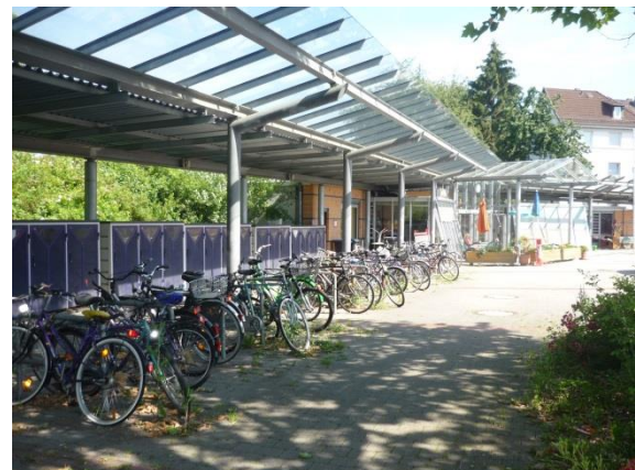
Abb. 6: Abstellanlagen am Bahnhof Northeim
